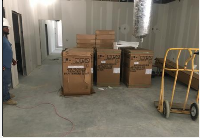
Fan Coil Units
